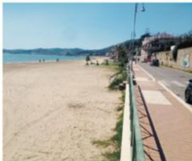
Le spiagge di Vindicio ed il comune di Formia. Sotto gli impianti
